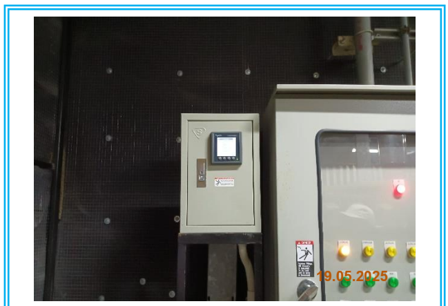
รูปที่ 3-15 มิเตอร์ไฟฟ้าของส่วนระบบบำบัดน้ำเสีย
