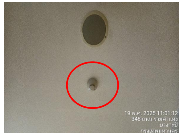
รูปที่ 2.9-2 Smoke Detector
