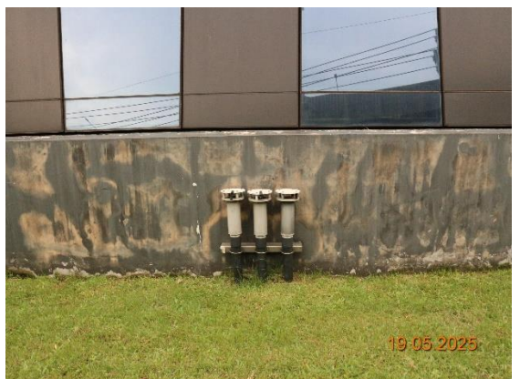
รูปที่ 3-11 ระบบกำจัดละอองน้ำเสีย (Aerosol)
