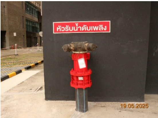
รูปที่ 3-45 หัวรับน้ำดับเพลิงภายนอกอาคาร
