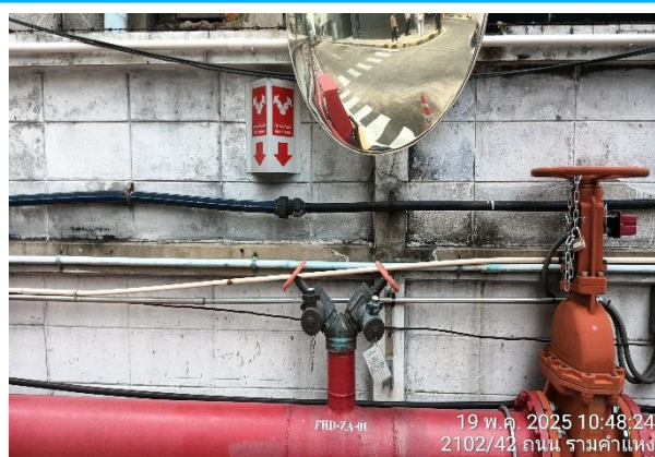
รูปที่ 3-42 หัวต่อสายฉีดน้ำดับเพลิง
