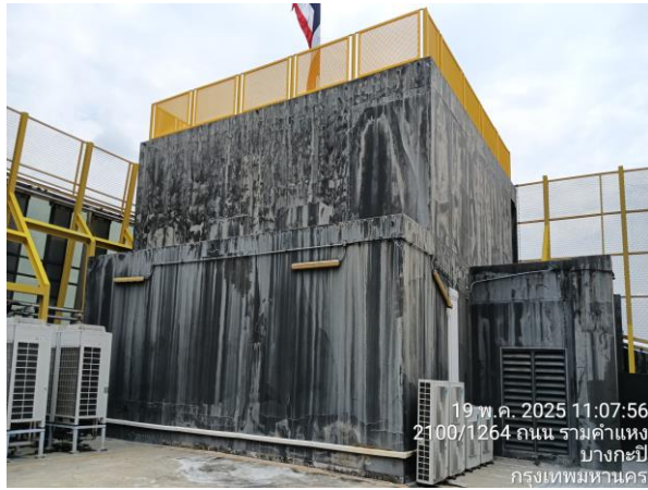
รูปที่ 3-21 ถึงสำรองน้ำใช้ของอาคารสำนักงาน
